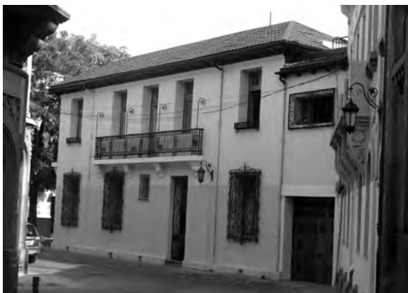
Figura 3. Calle Concha y Toro. Reciclaje de inmueble
