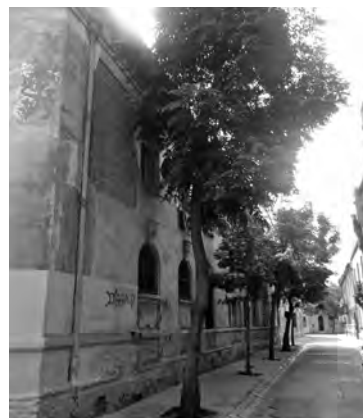
Figura 4. Persistencia del deterioro
