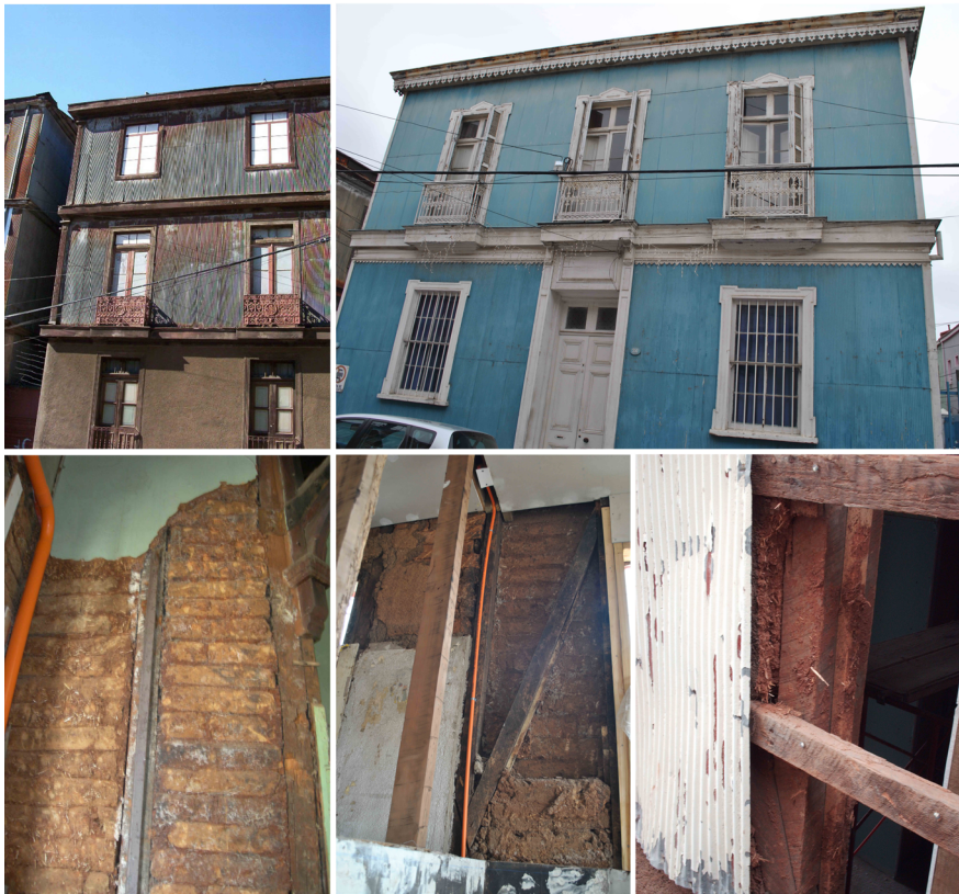
Imagen 9. Tipologías residenciales y tecnología del tabique de madera con adobillo en la cultura constructiva de Valparaíso (fuente: el autor).
