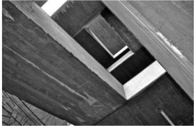
Imagen 8. Trama de vigas y losas, Unidad Vecinal Portales (fuente: Archivo Revista Arteoficio, Escuela de Arquitectura, Universidad de Santiago de Chile).
