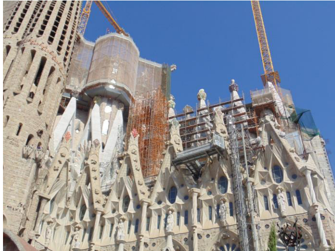
Figura 8: Iglesia de la Sagrada Familia, de Antoni Gaudí, en Barcelona, continúa en construcción. Fotografía: Abraham Padilla. (2014). Archivo fotográfico del autor.
