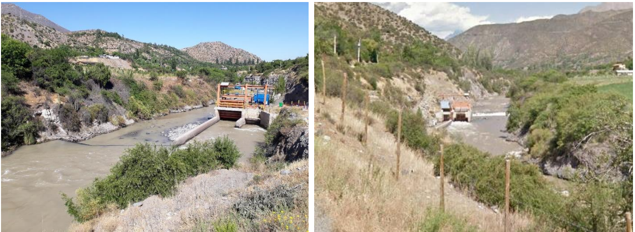
Figura 2.8: Vista desde aguas arriba (izquierda) y desde aguas abajo (derecha) bocatoma Canal Matriz, Primera Sección río Aconcagua.
