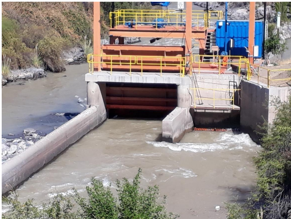
Figura 2.12: Vista desde aguas arriba compuertas en bocatoma Canal Matriz, Primera Sección río Aconcagua.
