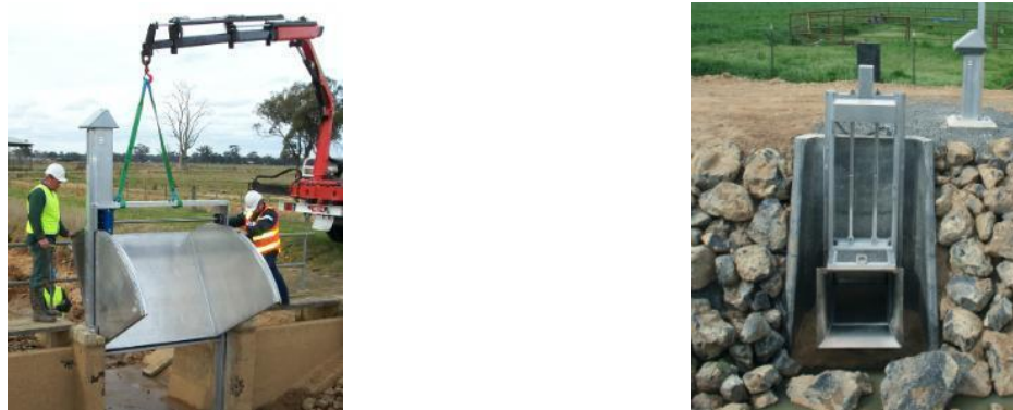
Figura 2.26: Compuertas FlumeGate (izquierda) y SlimMeter (derecha).
