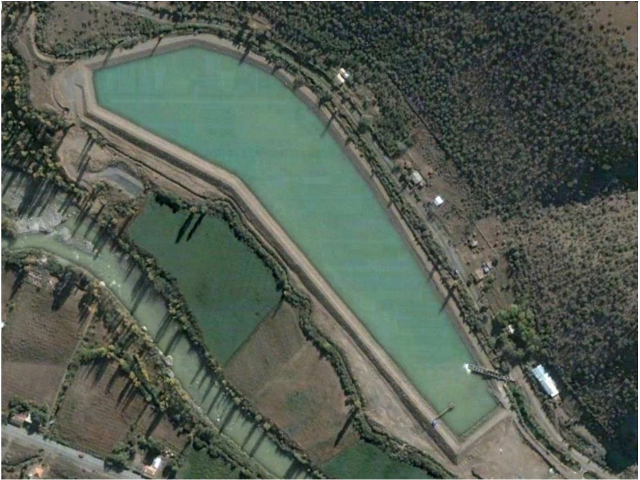
Figura 2.16: Vista aérea Tranque Vizcachas, Primera Sección río Aconcagua.
