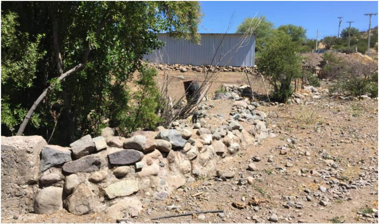
Figura 4.5: Vista hacia aguas arriba de la quebrada "El Huape". Modificado de MAS Recursos Naturales S.A. & WATS, 2016.
