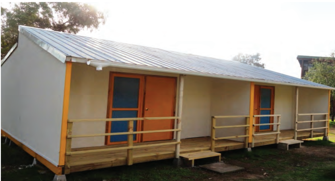
Figura 1: Prototipo de Viviendas pareadas instaladas en Santiago, zona térmica 3
