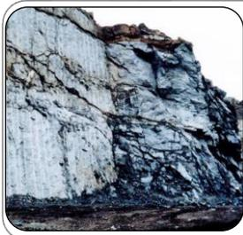
Pequeñas voladuras en taludes de ingeniería civil dan lugar a pequeños daños al macizo rocoso, particularmente si se usan voladuras de contorno como se muestra en el lado izquierdo de la fotografía. Sin embargo la liberación de tensión resulta en alguna alteración.
