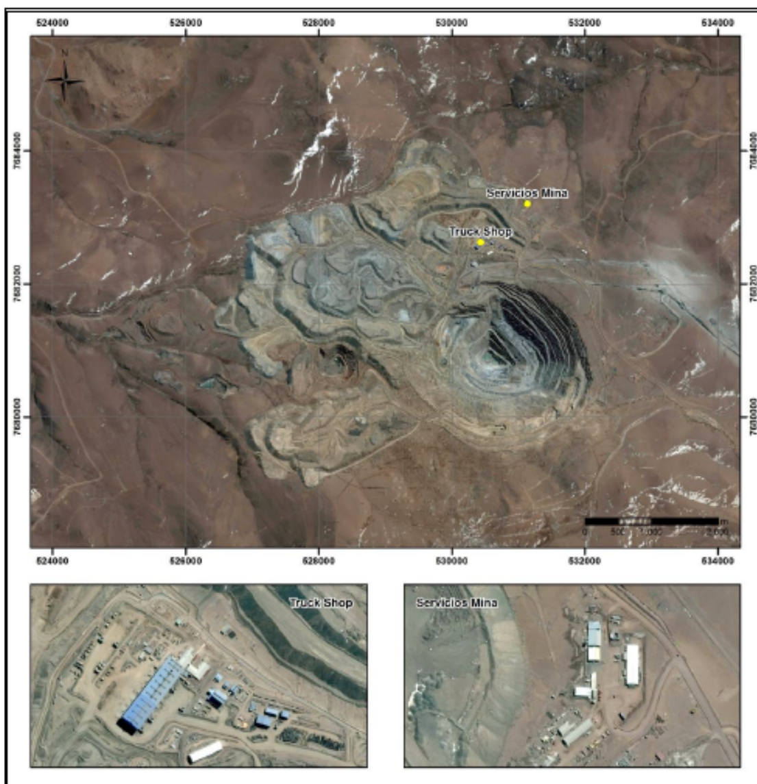
Figura 4.3 Instalaciones en Área Cordillera (Rajo Rosario). Fuente: Compañía Minera Doña Inés de Collahuasi, 2014.
