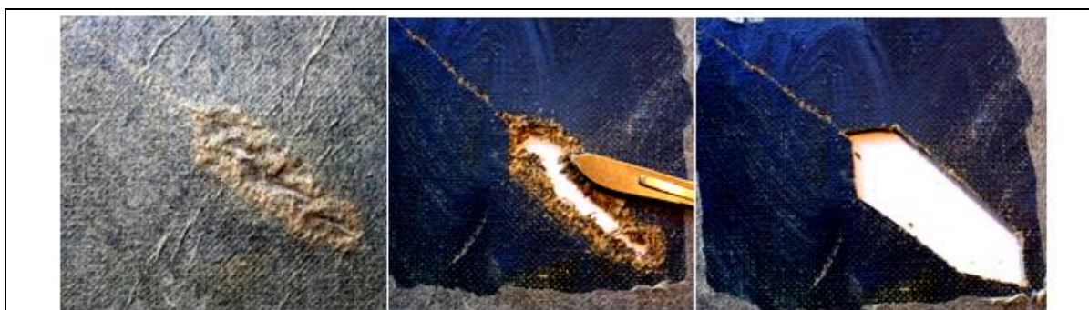
Fig.101 Proceso de limpieza de faltantes
