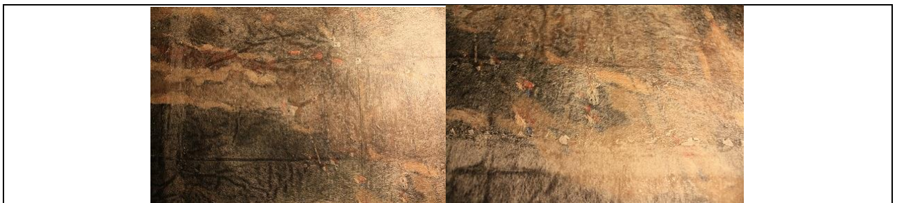
Fig. 34 Imagen de la obra post aplicación de calor.
