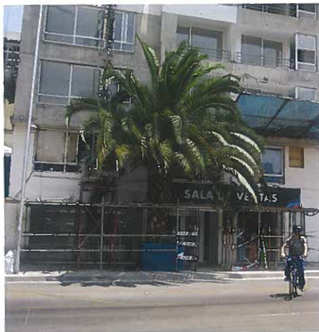
Veredas extremadamente angostas en vías con alta circulación de vehiculos, como en este caso de calle Carmen entre Marin y Santa Victoria, año 2012.
