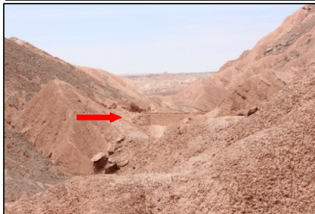
Figura B7. Arriba, entrada oriental del Túnel Los Toros en la actualidad. Figura B8. Abajo, puente que forma parte de la tecnología del movimiento asociada al camino automovilístico que conectó San Pedro de Atacama y Calama desde circa 1930.
