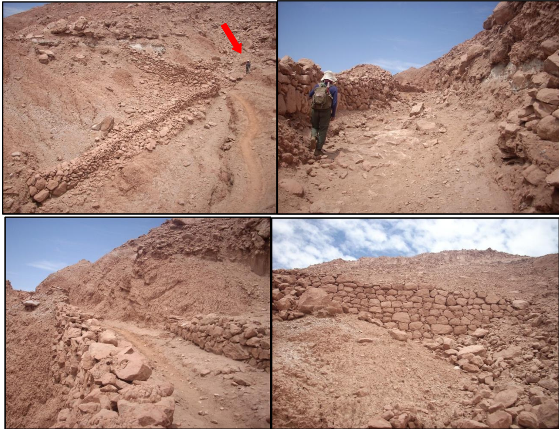
Figura 40. Arriba a la izquierda, “Tecnología del arreo” de la Cuesta Los Toros, envergadura de algunos tramos de muros, la flecha marca la escalera humana. Figura 41. Arriba a la derecha, ejemplo del alto del muro de contención en algunas secciones. Figura 42. Abajo a la izquierda, muro de contención y aterrazado. Figura 43. Abajo a la derecha, selección de bloques y encaje.
