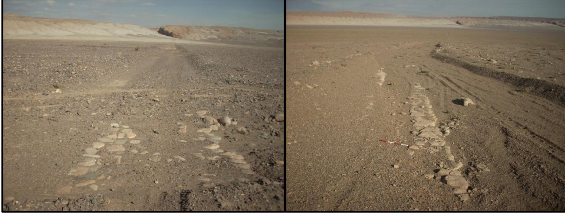
Figura 16. Izquierda, pavimento de clastos canteados que forma un badén. Figura 17. Derecha, dos huellas paralelas de clastos canteados.
