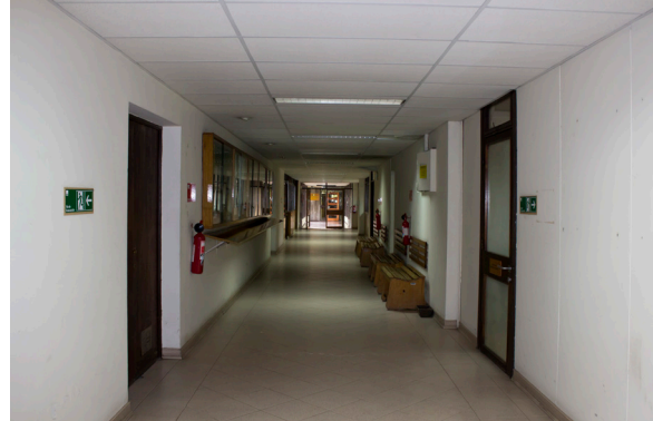
Situación actual pasillo central interior zona del zócalo sector Sur con poca iluminación y aprovechamiento del paisaje circundante.
