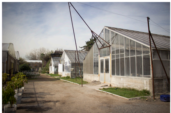
Fig 18: Invernaderos, parte de los edificios dedicados exclusivamente a la investigación, forma un conjunto con edificios de diversos departamentos de la Facultad de Ciencias Agronómicas. Fuente: Elaboración Propia
