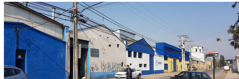
Imagen propia - Zona de Industrias y bodegas
