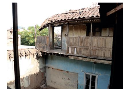
El techo presenta muchos daños causados por los terremotos, los mayores deterioros están presentes en la cercha de madera y en la cubierta. Ésta ha permitido la infiltración de agua a los pisos de abajo. Eso es una de las causas principales, además del terremoto, del deterioro presente en la fachada al segundo piso y también al primero.
