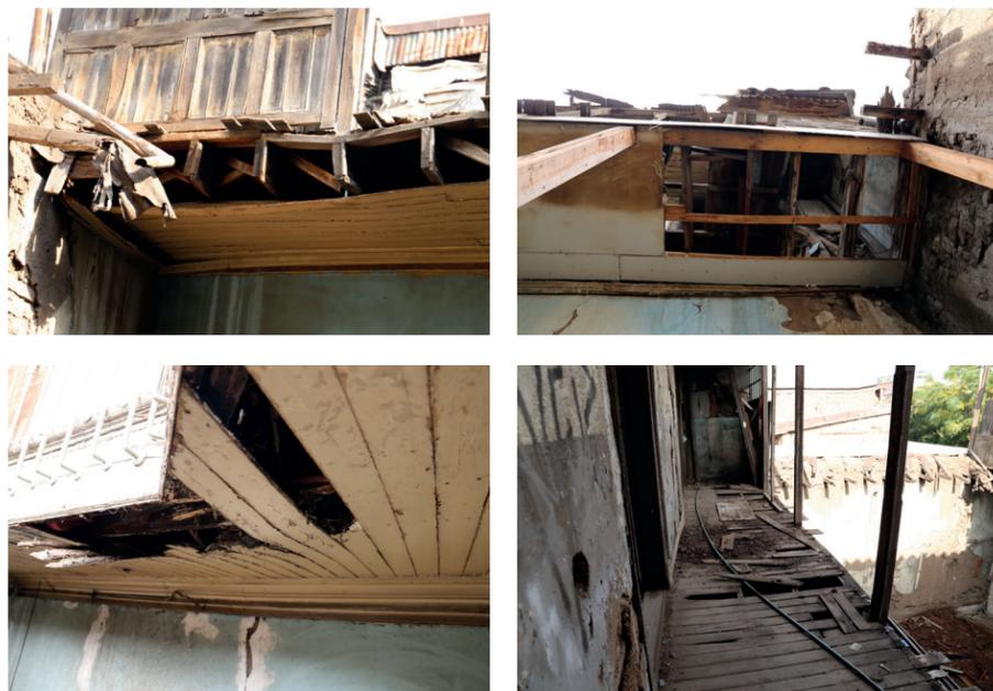
*La estructura del entrepiso presenta algunas degradaciones producidas por acciones mecánicas como el sismo y acciones físicas como las infiltraciones, que han llevado a la pérdida de los elementos de madera del revestimiento del entrepiso y a la siguiente deformación.*
