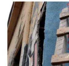
**Inflamación.** Levantamiento superficial y localizado material, que asume forma y consistencia variables.
