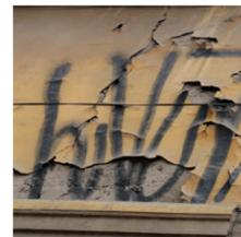
**Exfoliación.** Degradación que se manifiesta con separación a menudo seguida por caída, de uno o más capas superficiales subparaleli entre ellos (hojas).
