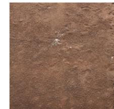
**Concreción.** Depósito compacto formado por elementos de extensión limitado desarrollado en una sola dirección que no coincide con la superficie pétreas. Puede asumir forma estalactita o de la estalagmita. La formación de concreciones se averigua sobre materiales calcáreos, areniscas, travertino en presencia de permanencias húmedas, dilatado en el tiempo, en entorno propretretto con migración, depósito y mineralización de sales.
