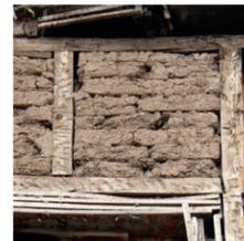
**Falta.** Caída y pérdida de partes. El término, genérico, se usa cuando tal forma de degradación no es describible con otras voces del léxico. En el caso particular de los revoques pintados se afana de preferencia deficiencia.
