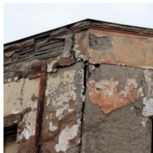
**Fracturación o grieta.** Degradación que se manifiesta con la formación de soluciones de continuidad en el material y que puede implicar el desplazamiento recíproco de las partes.
