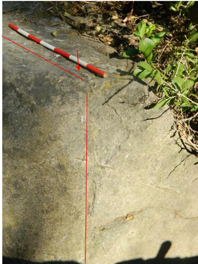
Figura N° 13. Bloque con evidencia de corte en línea de fractura y marca de cuña en la parte superior.
