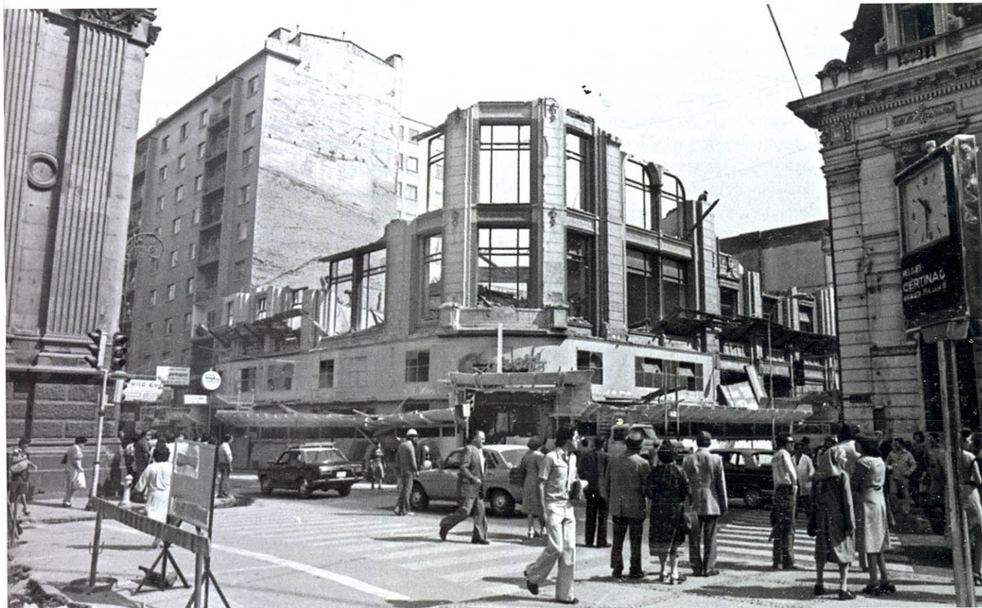
Calle Puente esquina Catedral, demolición edificio Krauss año 1980.
