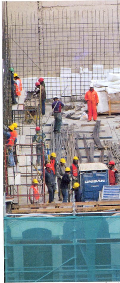
Remodelación interior edificio calle Puente esquina surponiente calle Santo Domingo, 2006.
