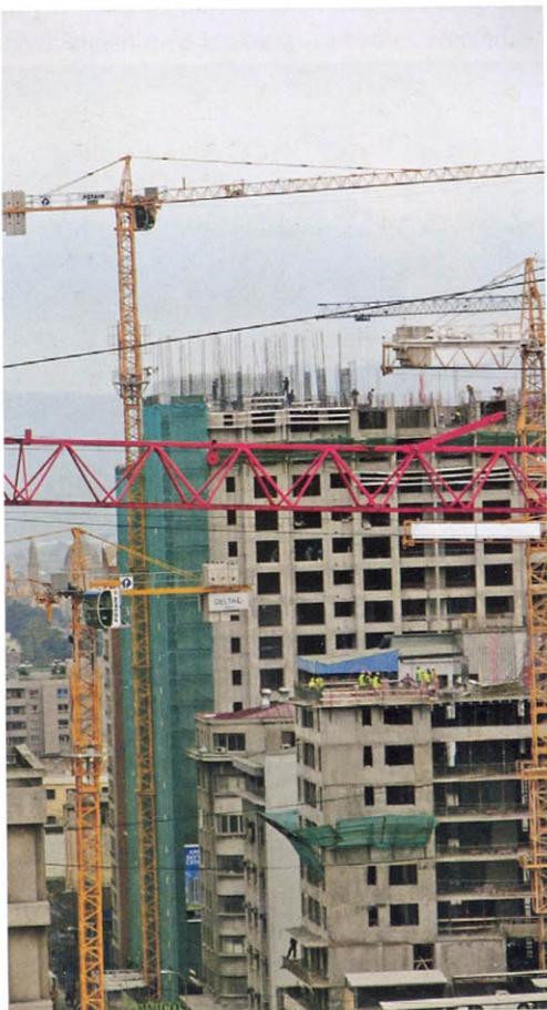
Viviendas en altura en construcción, 2006.
