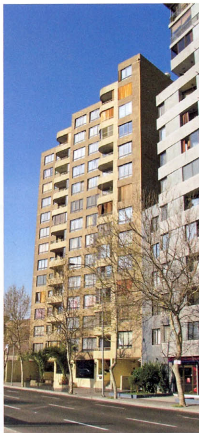
Edificio de vivienda, Av. M. Rodríguez Norte N° 75-81
