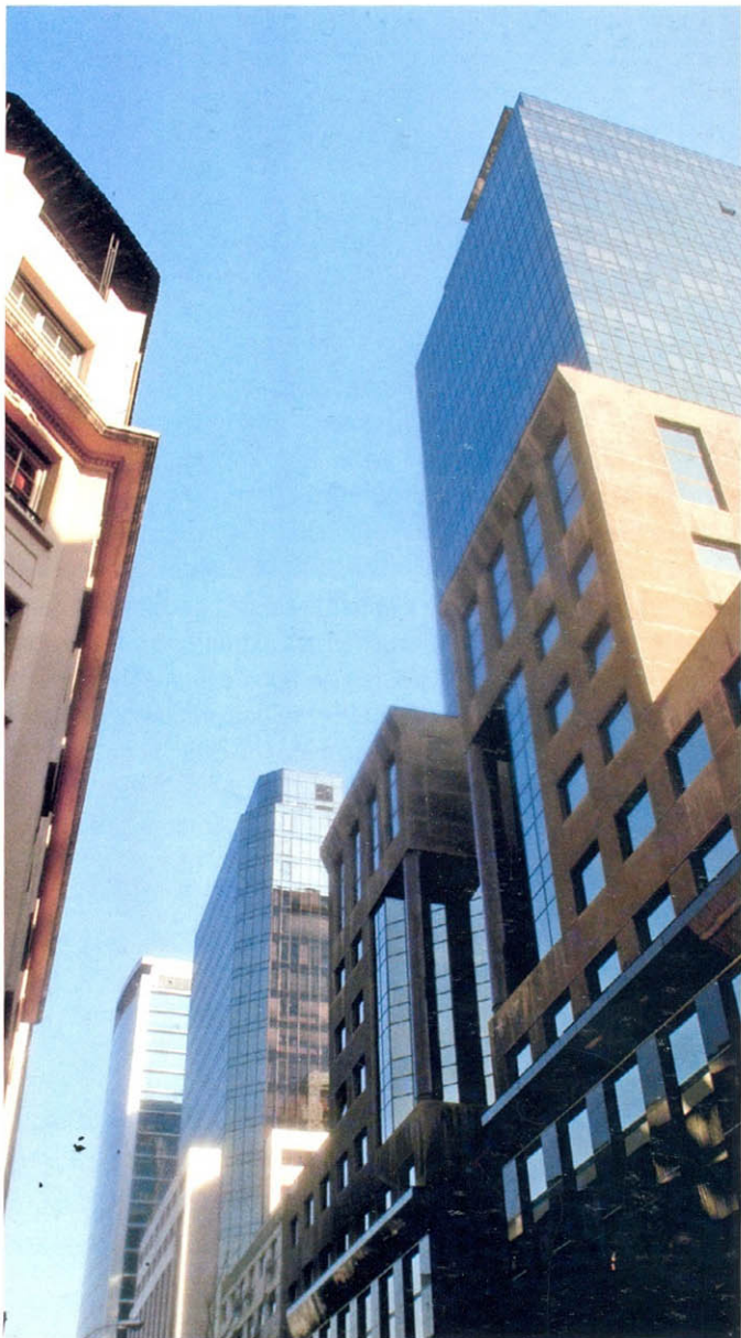
Calle Miraflores, en primer plano edificio Las Américas, arquitectos Cristián Boza, Hernán Duval y Manuel Moreno, 1988.
