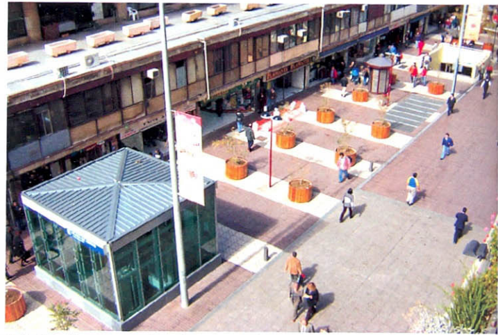
Calle 21 de Mayo, acceso al estacionamiento subterráneo.
