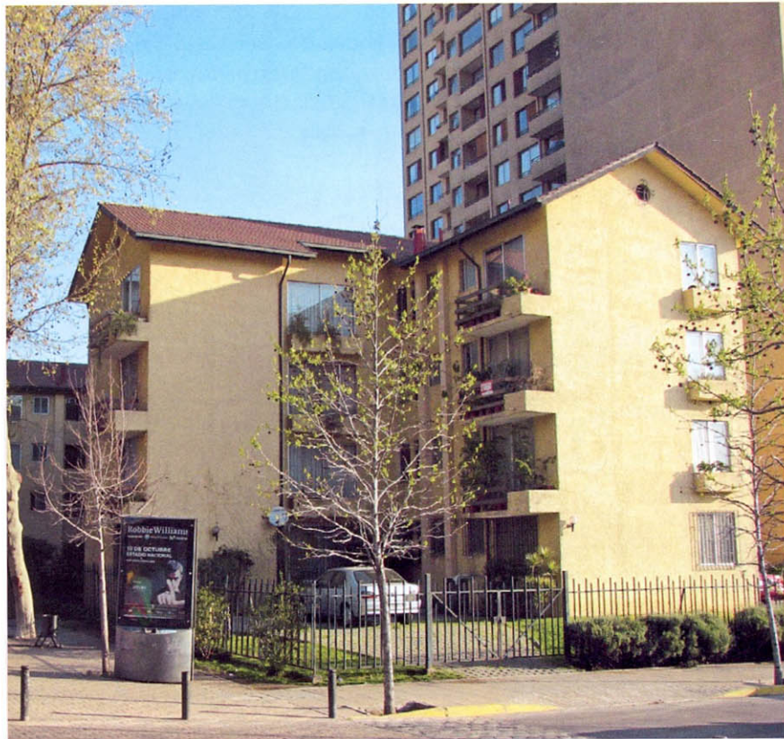
Conjunto habitacional en Catedral N° 1546-1564 y calle San Martín N° 450-492.
