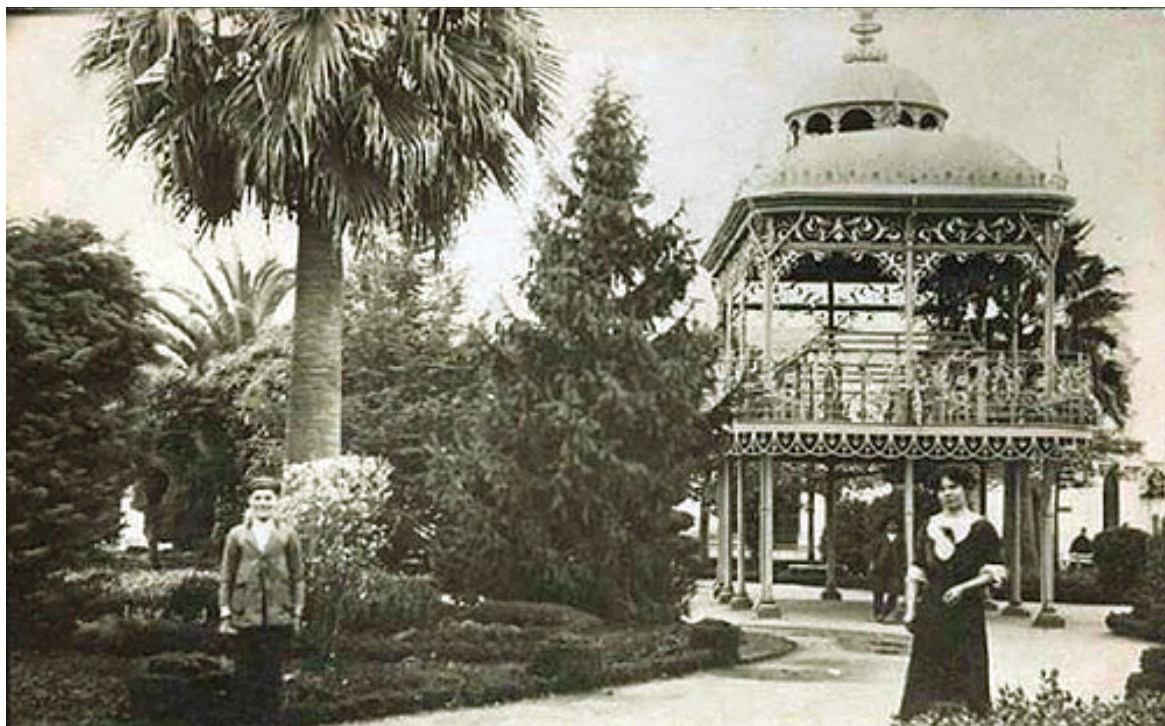
Quiosco Cívico de la Plaza de Armas de Curicó en sus inicios. Un patrimonio arquitectónico muy valorado en la ciudad.
