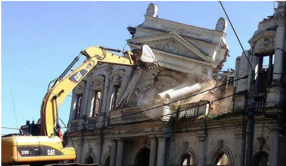
Demolición del Club de La Unión en septiembre de 2016; uno de los edificios que enfrentaba a la Plaza de Armas de Curicó.
