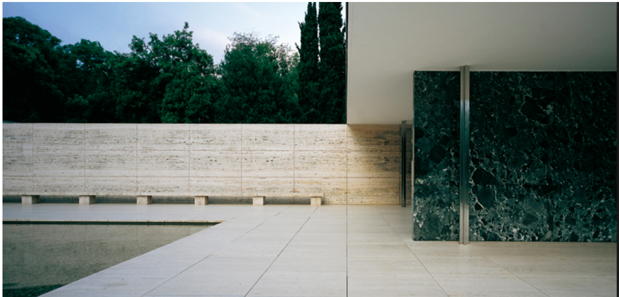
Figura 5: Mies Van der Rohe (1986). Pabellón Alemán en Barcelona.
