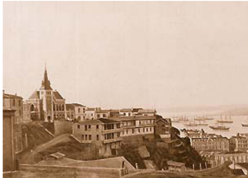
● Figura 27 Fotografía sector estanque previo a su construcción Fuente:www.valparaisohistorico.cl
