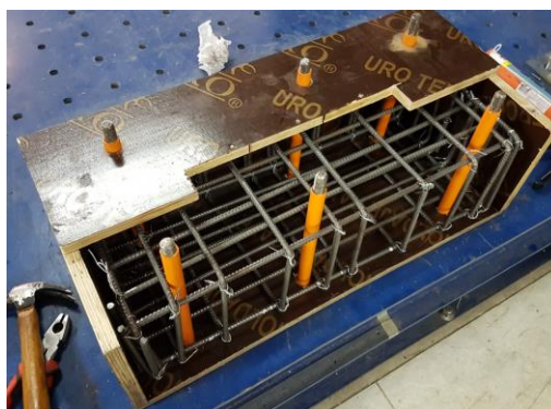
Figura 7-11: Armadura y moldaje fundación
