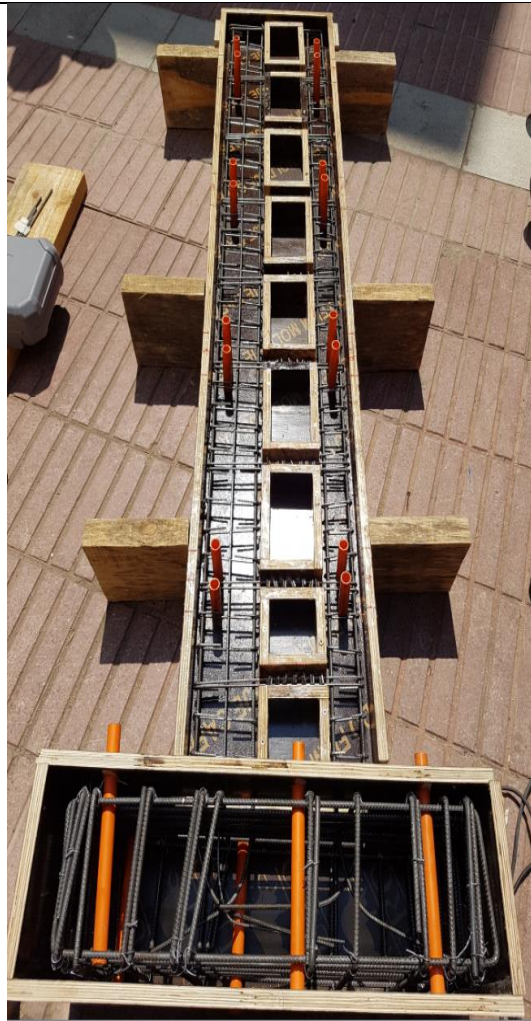
Figura 7-14: Probeta N°3 Pre-Hormigonado
