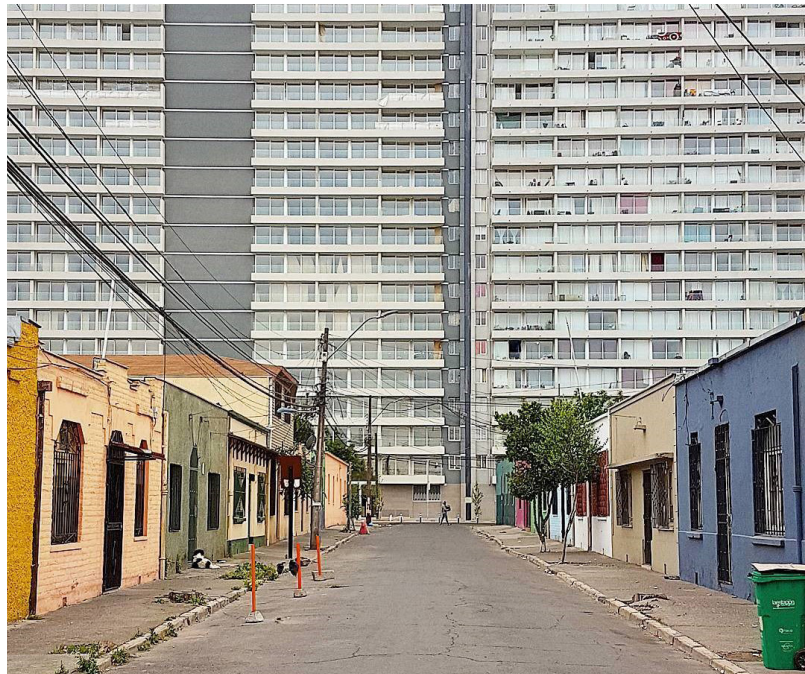
Figura 11. Fotografía ilustrativa de la falta de privacidad debido a los denominados "Mega edificios" desde la perspectiva de las viviendas afectadas. Fuente: Reportaje "Las nuevas "callampas": Boom inmobiliario en Estación Central" extraído de [ https://www.elciudadano.cl/reportaje-destacado/las-nuevas-callampas-boom-inmobiliario-en-estacion-central/ ].
