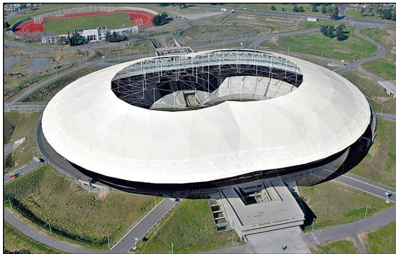
Figura 37. Fotografía aérea del estadio Unico de La Plata. En ella se puede ver el entramado de cables que forman parte del sistema de Tensegrity. ( http://tensegritywiki.com/La+Plata+Stadium ).
