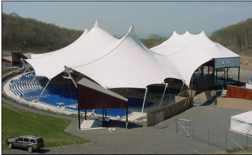
Figura 12. Techo sobre centro deportivo. En esta imagen se muestran las curvaturas que pueden alcanzar las membranas. ( http://www.architen.com/products/standard-system-3/ ).
