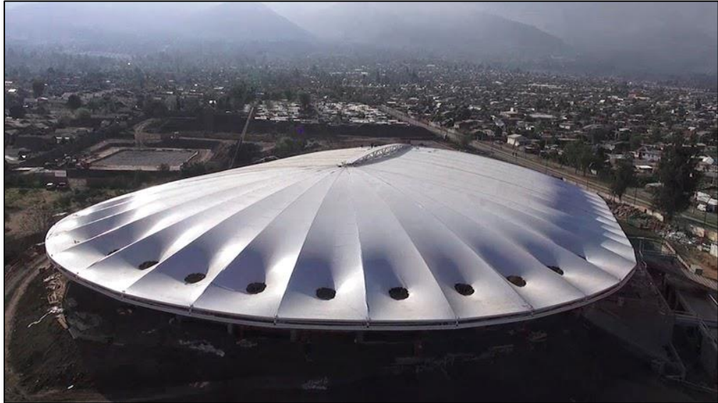
Figura 13. Velódromo de Peñalolén. El techo es construido con membranas tensadas como se observa en la imagen ( http://www.disenoarquitectura.cl/velodromo-penalolen/ ).
