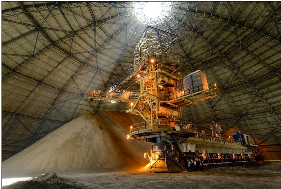
Figura 35. Domo en minera de Zinc Skorpion, Namibia. Estructura similar a la considerada en este trabajo. ( http://www.mining-journal.com/profit-amp-loss/news/1311390/zinc-production-prices-boost-vedanta-earnings ).
