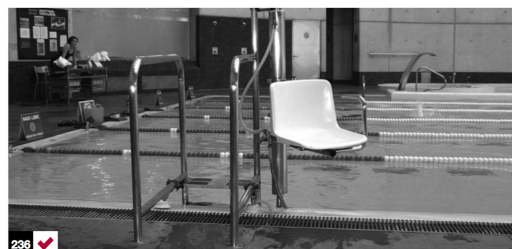
Foto 236: elevador hidráulico para acceder a la piscina. Santiago, Chile.
