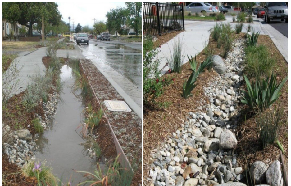
Zanja de infiltración (Bioswale) . Fuente: Kimiaiberica
