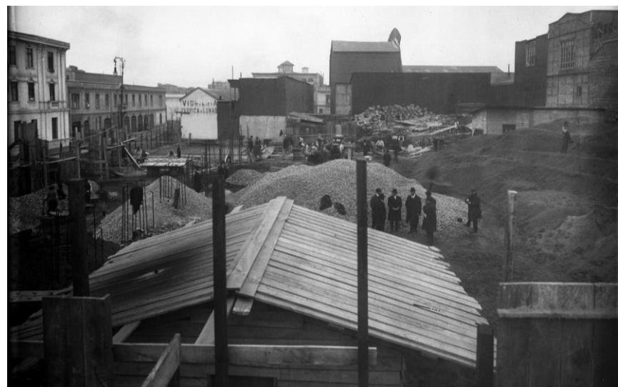
Figura. 25 Obras de construcción Escuela Ramon Barros Luco/ Fuente: DAMOP
