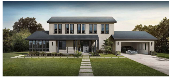
Vivienda con Tejado Solar
