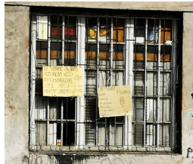
Es posible encontrar distintos tipos de avisos de arriendo de piezas y pequeño comercio informal caracterizado por la muestra de la cultura a través de la comida
