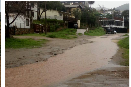
8. Viviendas colindantes quebrada
