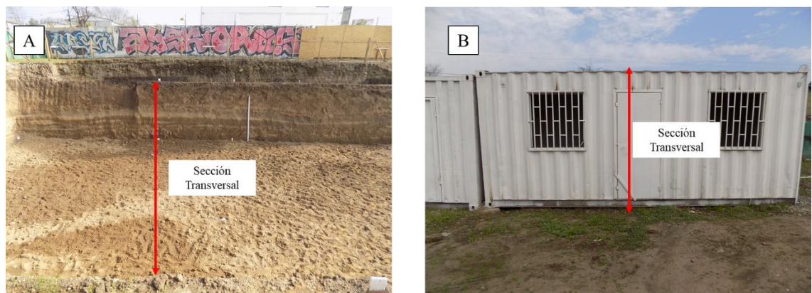
Figura 7.1: Recomendación en la toma de imágenes. (A) Excavación de edificaciones, (B) Rellenos o edificaciones de mediana altura.
