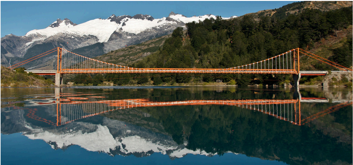
Linealidad funcional y su rol en el paisaje. Fotografía del puente de la Carretera Austral que cruza sobre el desagüe del Lago general Carrera. 44
