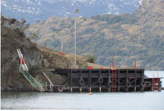
Fotografía del Antiguo Muelle, actualmente en recuperación 35
