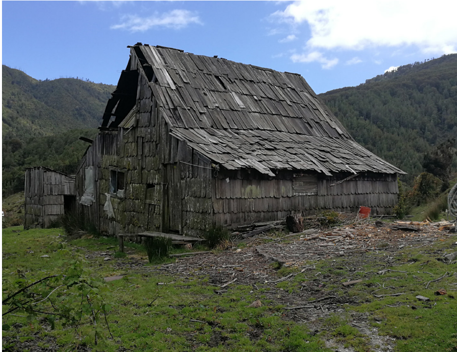
Figura 33: Galpón en desuso, construcción más antigua de Manquemapu. Fuente: ONG POLOC.
