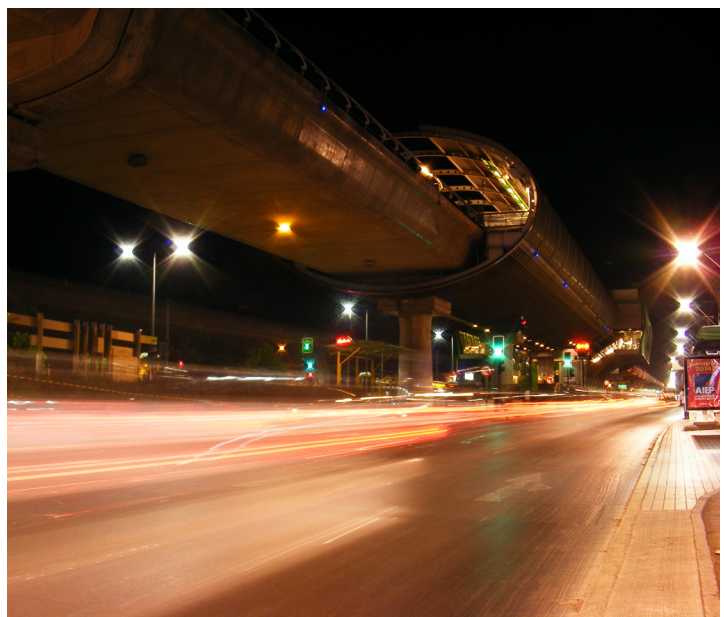
Fig. 0 | Infraestructura Urbana de Movilidad: Metro de Santiago, Línea 5
