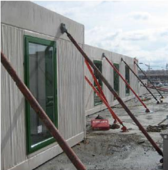
Anexo 13. Imágenes de montaje de Sistema arquitectura vertida. Fuente: POSTELÉCTRICA S.A.
