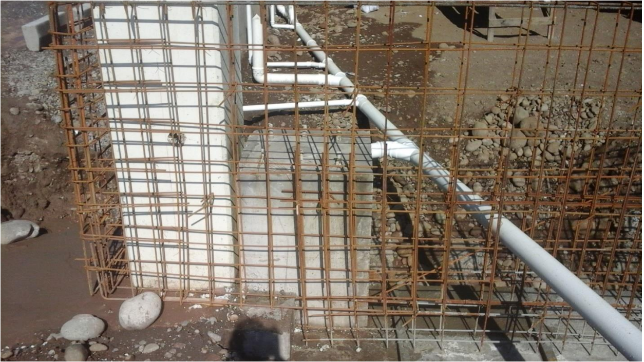
Anexo 11. Foto a fundación de Sistema TENSOCRET. Fuente: Elaboración propia.
