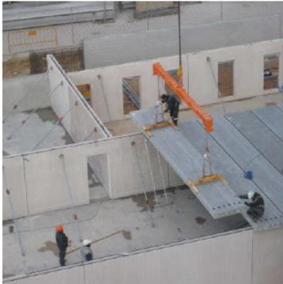
Anexo 15. Imágenes de montaje de Sistema arquitectura vertida. Fuente: POSTELÉCTRICA S.A.
