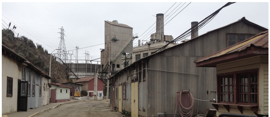
fig 43. Playa chica y muelle. Fuente: Fotografía de autora fig 44. Patio de alta tensión y muelle. Fuente: Fotografía de autora fig 45. Construcciones aledañas. Fuente: Fotografía de autora
