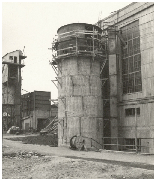
fig 11. "Construcción Sala de Calderas. 1949"
