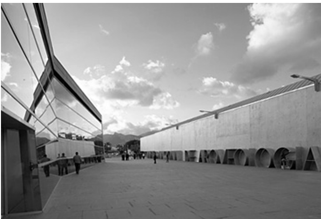
Ubicación: Cartagena, Murcia, Spain Arquitectos técnicos Marcos Vázquez Consuegra y Mariano García
