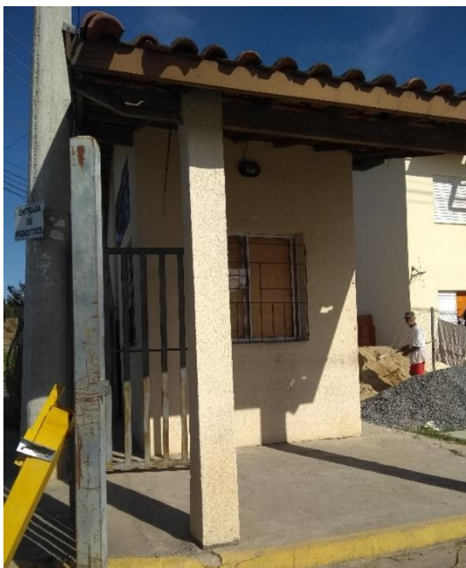
Figura 14: Cabina del portero cerrada
