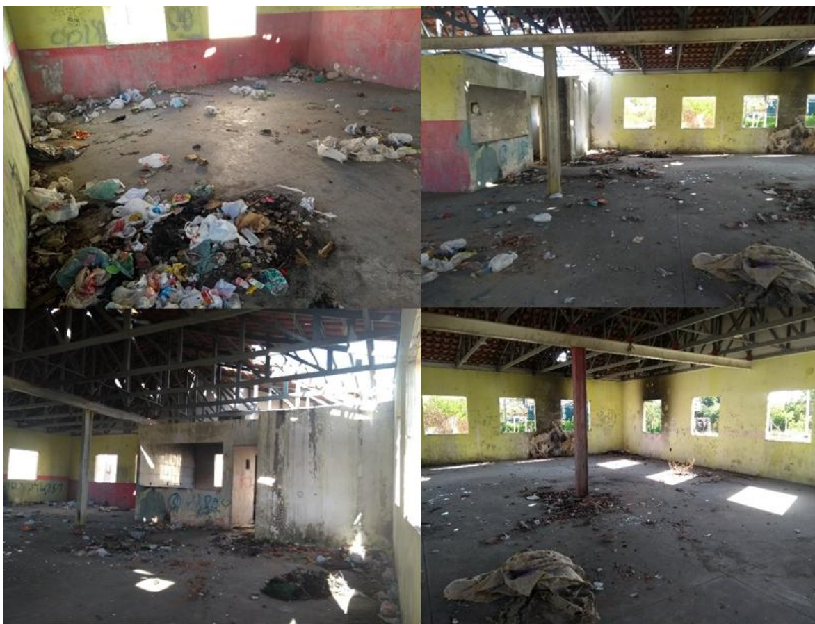
Figuras 19, 20, 21 y 22: Interior del salón comunitario
