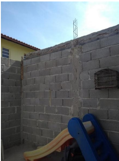
Figura 11: Construcción patio trasero
