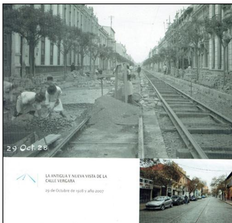
Figura 20. Fotografía calle Vergara, año 1928. Instalación de Redes Eléctricas Subterráneas. Fuente: Chilectra (2001)
