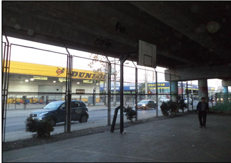
Figura 38. Multicancha gestionada por Grupo Abertis S.A. Fuente: Renata Porcell Lizama (2018)
