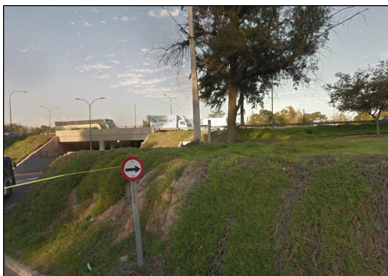
Figura 12. Bypass soterrado enlace entre Av. Colón y Autopista Central. San Bernardo.
