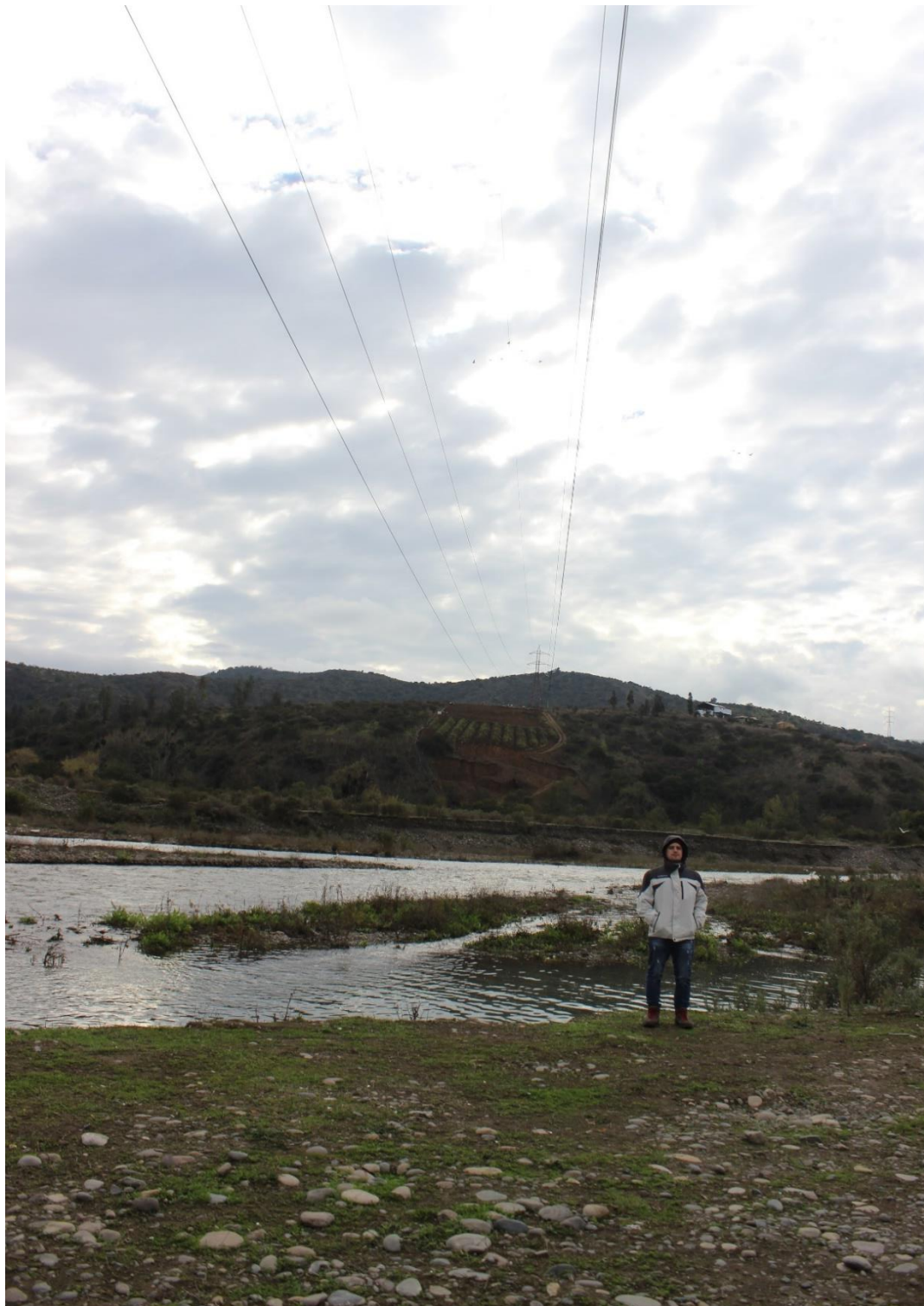
Anexo 1. Línea Quillota - Nogales 220 Kv atravesando hacia el norte el río Aconcagua en las cercanías del sector de Valle Alegre comuna de Quillota. Fuente: colección propia
