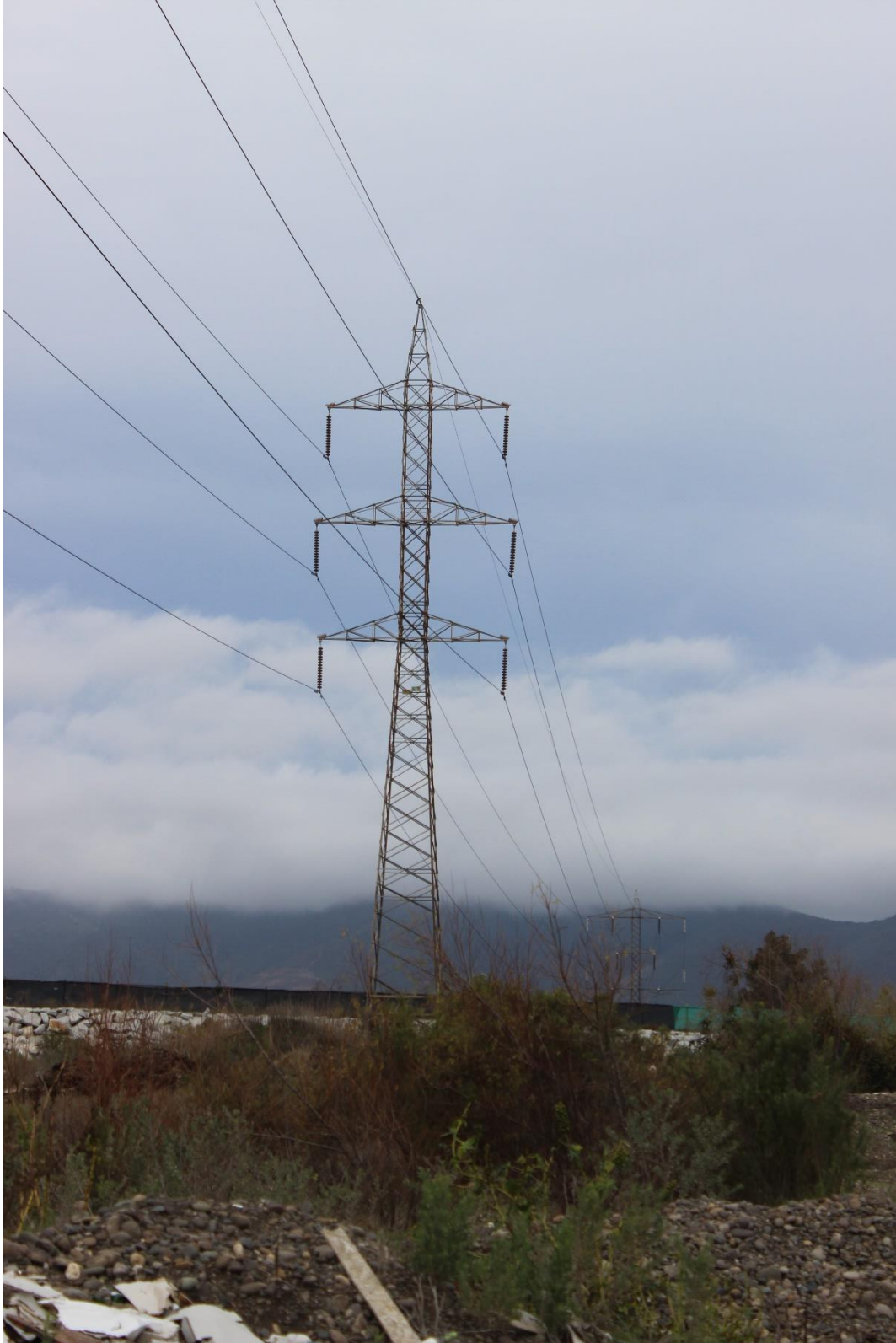
Anexo 2. Línea Quillota - Nogales 220 Kv atravesando hacia el sur el río Aconcagua en las cercanías del sector de Valle Alegre comuna de Quillota. Fuente: colección propia
