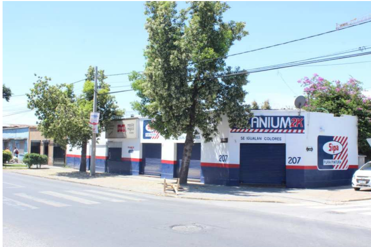
Imagen 45. Uso Ferretería. Fuente propia.
