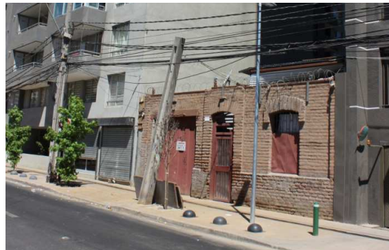
Imagen 51. Casa entre dos edificios, Av. Coronel Souper. Fuente: Imagen Propia.
