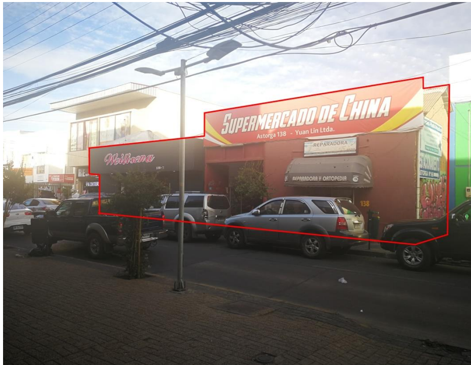
Imagen N° 1: Frente poniente del emplazamiento propuesto.
