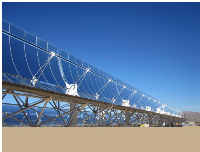
Figura 2.1: Colectores tipo cilindro parabólico. Fuente: Sun&Wind Energy
