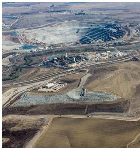
Figura 2.12: Planta hidrometalurgia y mina Corta Minera [14].
