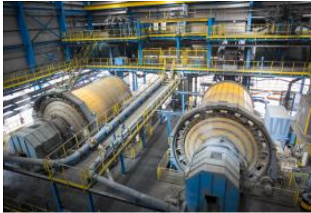
Figura 2.4: Planta de concentración de MATSA en la actualidad [9].
