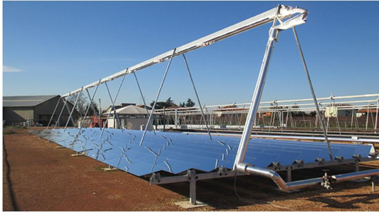
Figura 1.2: Colector solar Fresnel de la compañía Soltigua, modelo FLT.
