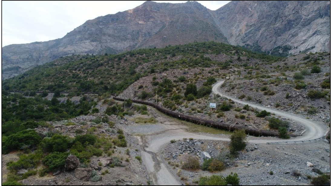
Figura 35: Depósito Pangal II sobre Pangal I. Se observa la zona de arranque de Pangal II. Vista al NO.
