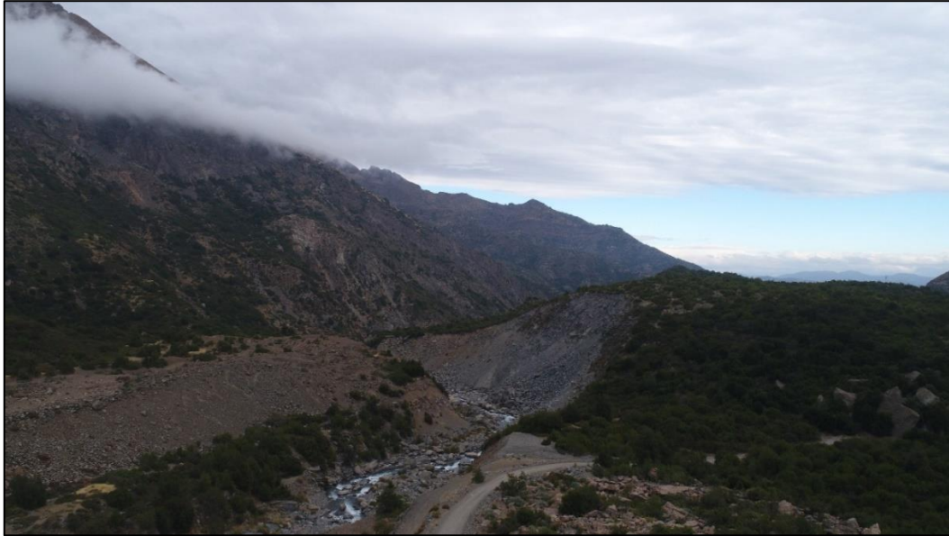
Figura 33: Al lado derecho del río se observa Pangal I, mientras que al lado izquierdo Pangal III. Se evidencian flujos y deslizamientos de las laderas de Pangal I. Vista al O.
