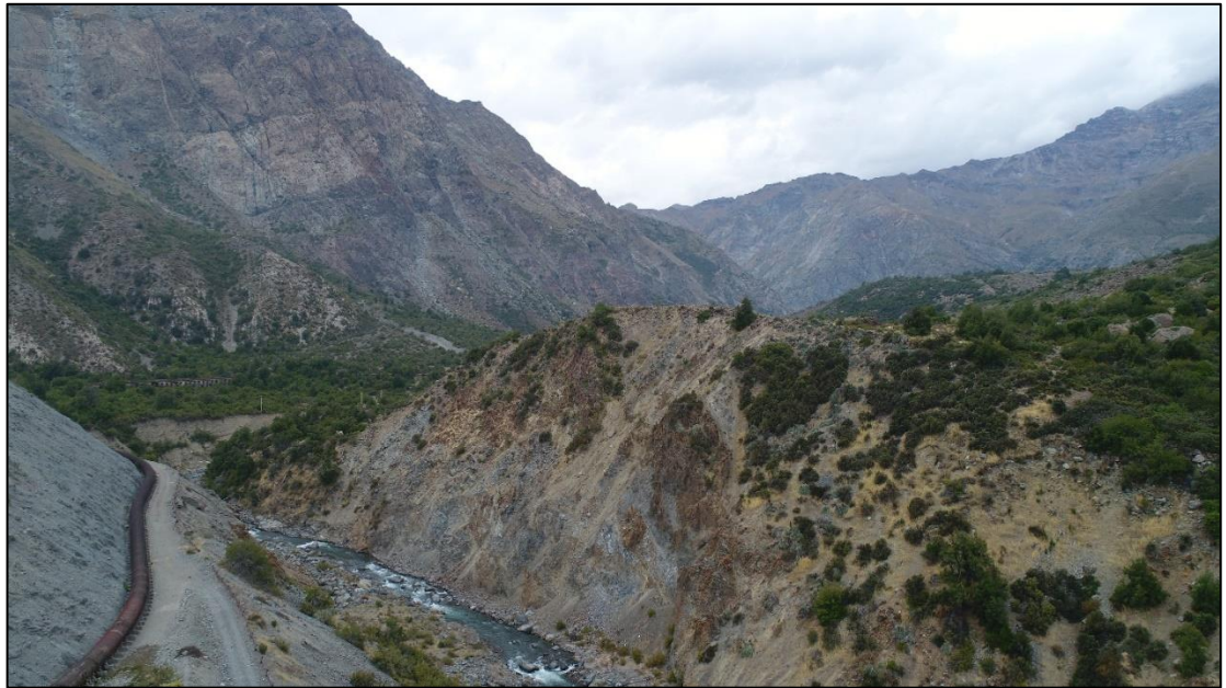
Figura 37: Depósito Pangal 3 con bloques alterados. Arcillas de alteración y oxidación. Vista al E.
