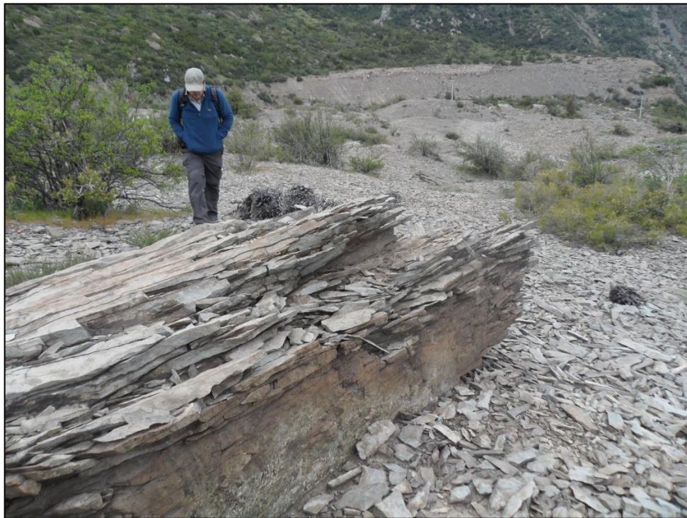
Figura 36: Zona con alto grado de lajamiento sobre Pangal II.
