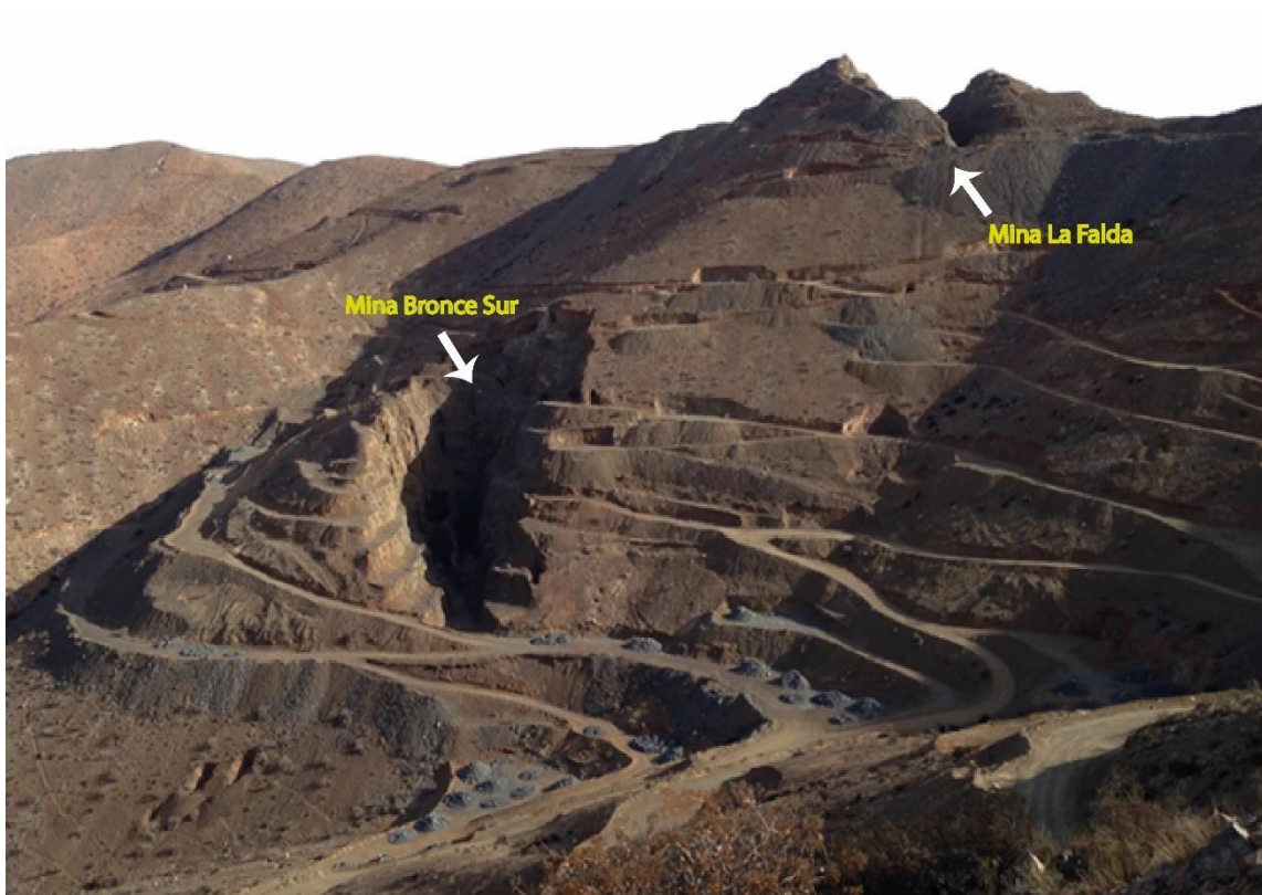
Figura 6: Vista desde subsector Pleito Sur hacia Rajos de Bronce Sur y Falda, Pleito Central.
