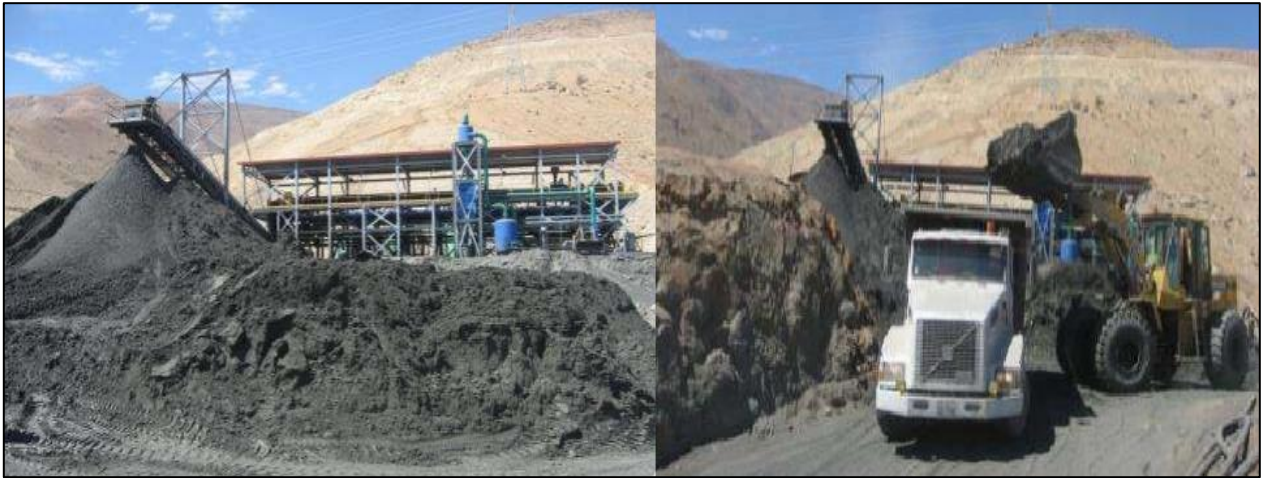
Figura 2.15. Transporte de relaves filtrados (Lara, 2017).
