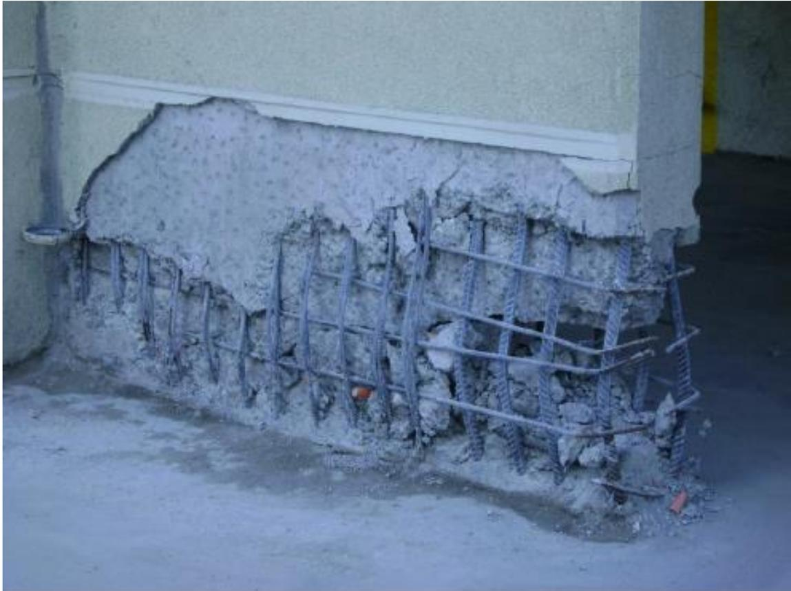
Figura 3.16 Daño estructural del muro de la fachada oriente (Leiva, Bravo, Matus, & Riquelme, 2010).
