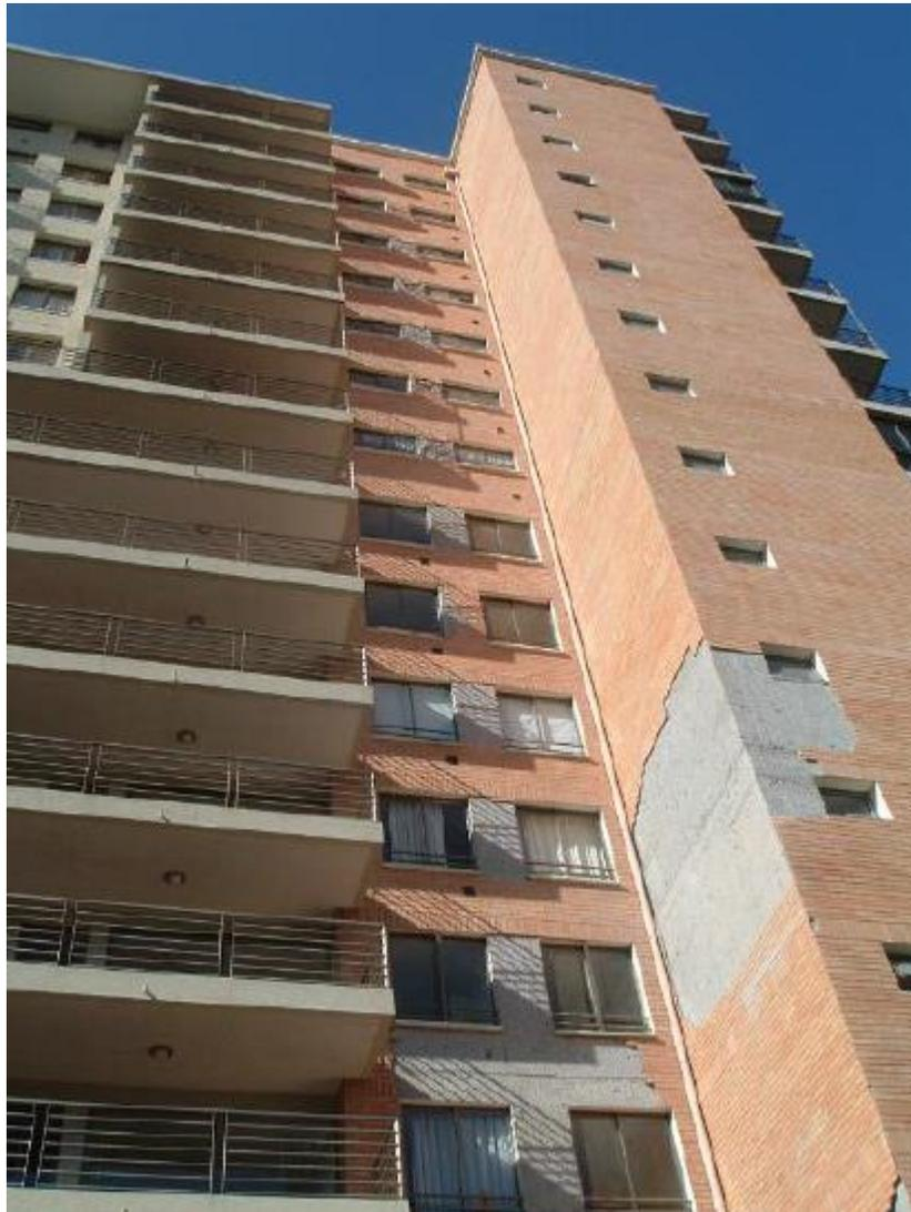
Figura 3.19 Desprendimiento del revestimiento exterior de machones en fachada norte (Leiva et al., 2010).
