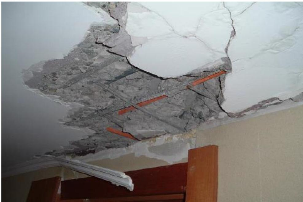
Figura 3.18 Grietas por acoplamiento de losas sobre dinteles de las puertas de acceso a los departamentos (Leiva et al., 2010).
