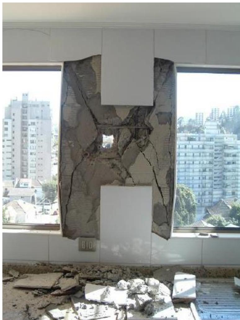
Figura 3.20 Falla de machón por corte vista desde el interior de un departamento del edificio (Leiva et al., 2010).
