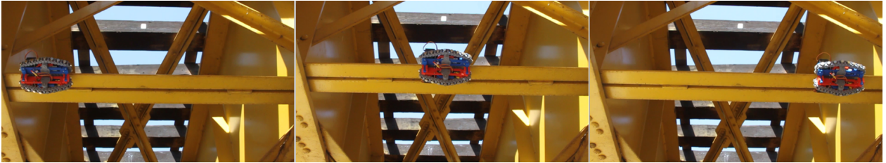
Figura 6.16: Transición de movimiento del robot sobre superficie horizontal de un enrejado interior del puente. Las barras metálicas tienen un grosor de 12.5[mm].
