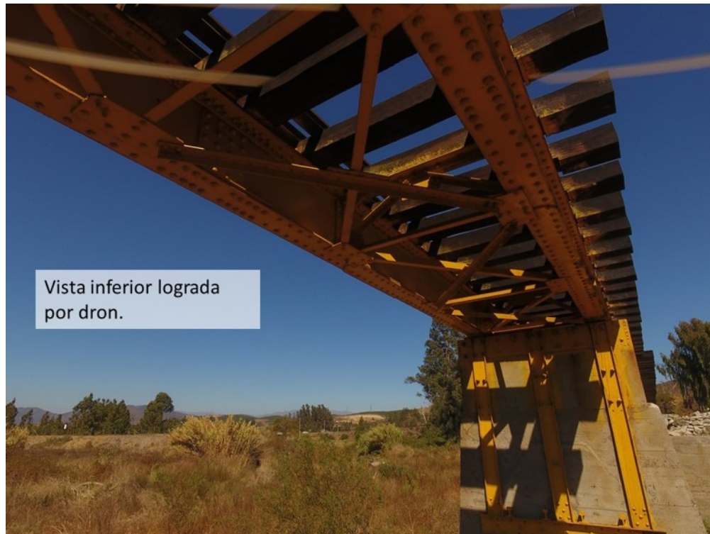
Figura 1.6: Vista lograda por dron volando bajo uno de los vanos.
