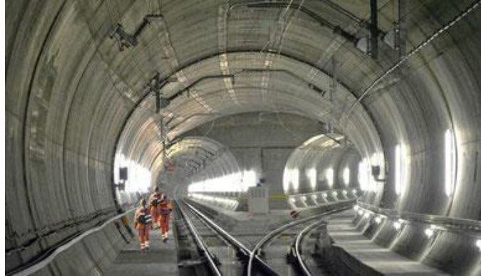
Figura 1.1: Túnel Línea 3 Metro de Santiago (Metro de Santiago, 2018)
