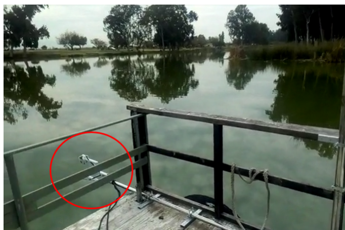
Figura 3.7: Instalación del instrumento Irgason en el muelle de la laguna Carén a 5 [m] de la ubicación de P3-Entrada PTAS.
